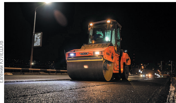
Некрасовский путепровод капитально не ремонтировали 15 лет.
