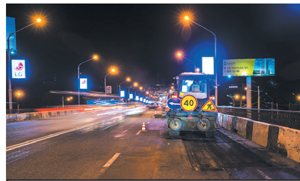
На Второй Речке снимают старый асфальт.
