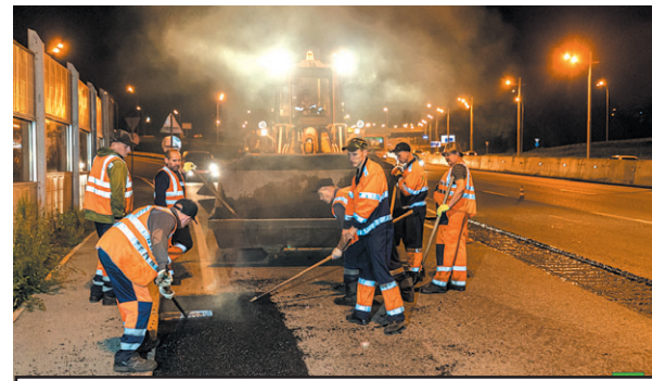
Работы ведут преимущественно ночью.
